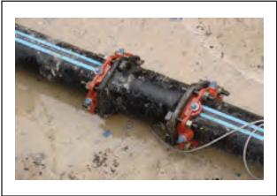
Fig. 23 "Mega-Lug" DIP Spool
